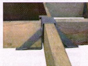
Fig. 4b Détail sabot simple (Frénéhard & Michaux)
